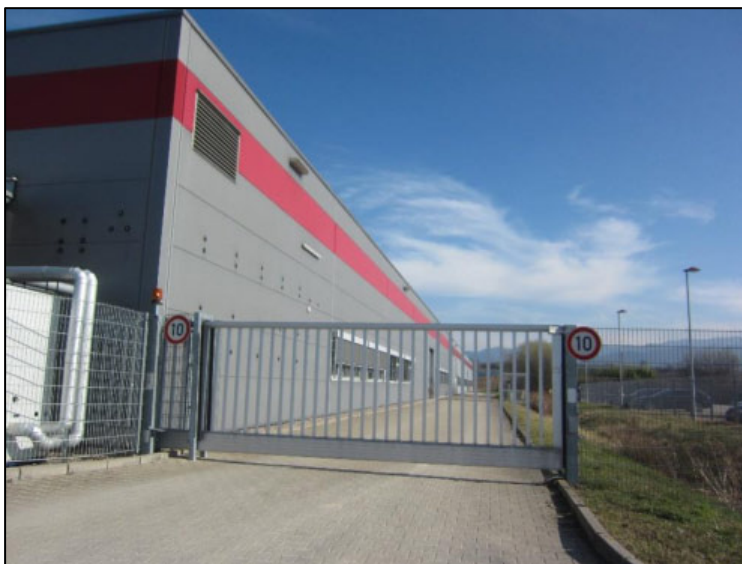
Abb. 4: Firmengelände mit kleiner Grünfläche
